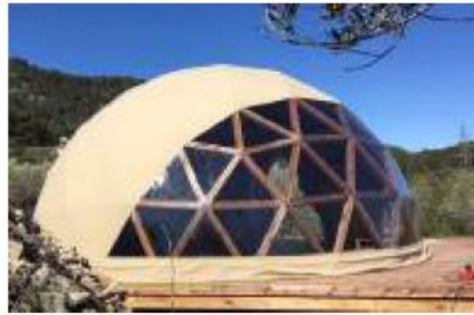
02. Imagen del acabado exterior una vez colocado el tejido de poliéster. (Fuente: www.daliadome.com )
